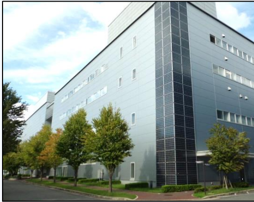
W3号館 外観
